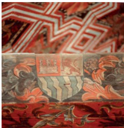
Fragmento de la armadura de influencia mudéjar y bóvedas de crucería de la capilla mayor.
